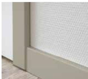
Durch eine Bekleidungsstärke/-dicke von 18,5 oder 20 mm werden z. B. unschöne Schnittkanten von Sockelleisten verdeckt.
